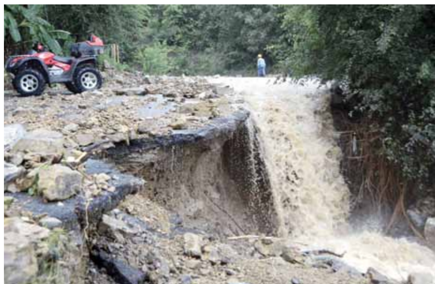
Un tramo de carretera en Monterrey fue destruido por las lluvias que provocó el huracán Ingrid.
