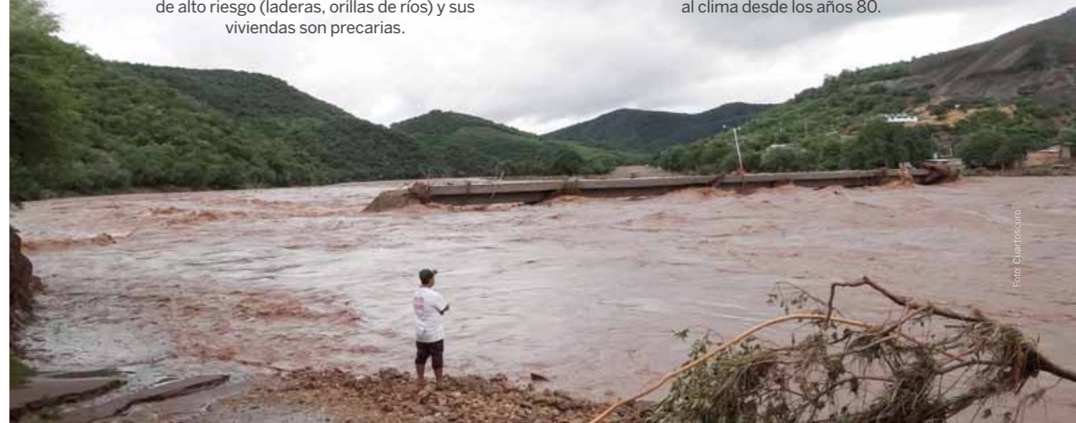
La tormenta tropical Manuel causó graves daños a mil 553 hogares en 27 comunidades del municipio de Huetamo, Michoacán.
